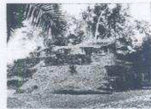
Edificio B-14, en el se realizó trabajos de control de vegetación
